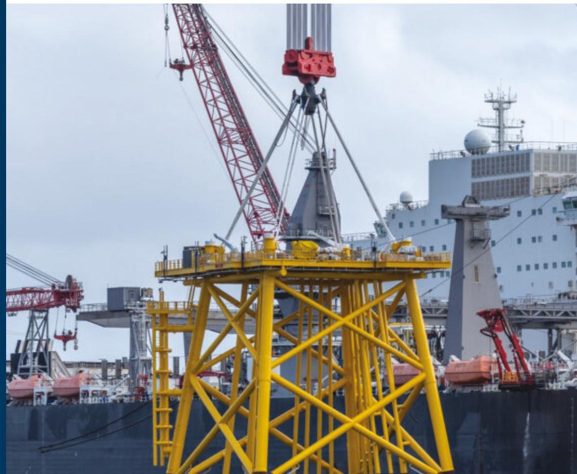
Pose d'une sous-station électrique permettant la concentration de l'électricité produites par les éoliennes (Parc de Saint-Nazaire).
