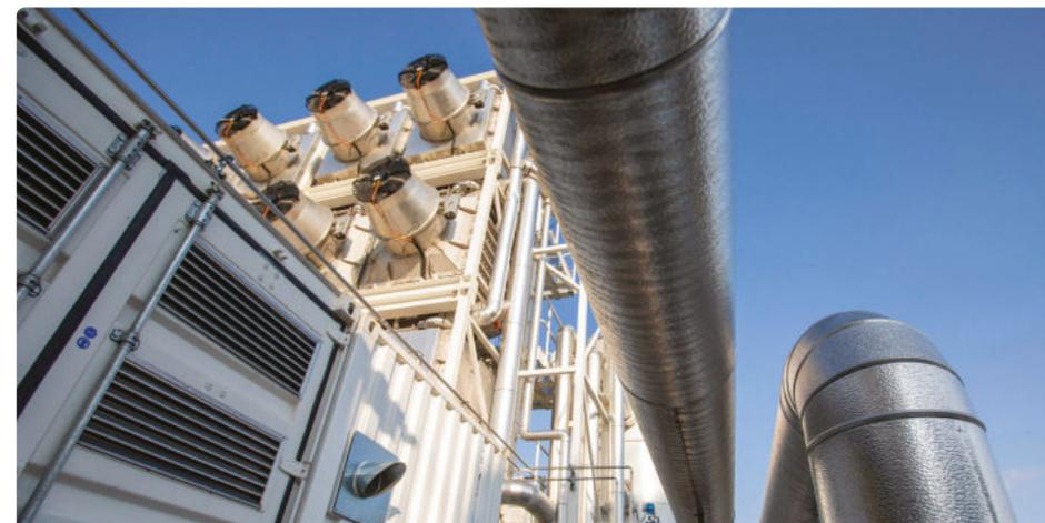
Installation de capture de CO<sub>2</sub> dans l'air de Climeworks. Le site a ouvert en septembre en Islande et permet de retirer 4000 tonnes de CO<sub>2</sub> par an.
